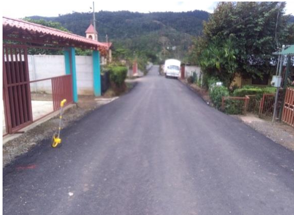
Asfaltado 400 metros Canadá – El Carmen de la Suiza
