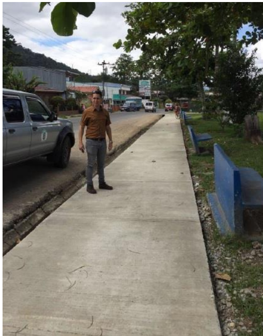
Impuesto al Cemento: Construcción de acera en La Suiza, frente a la plaza.
