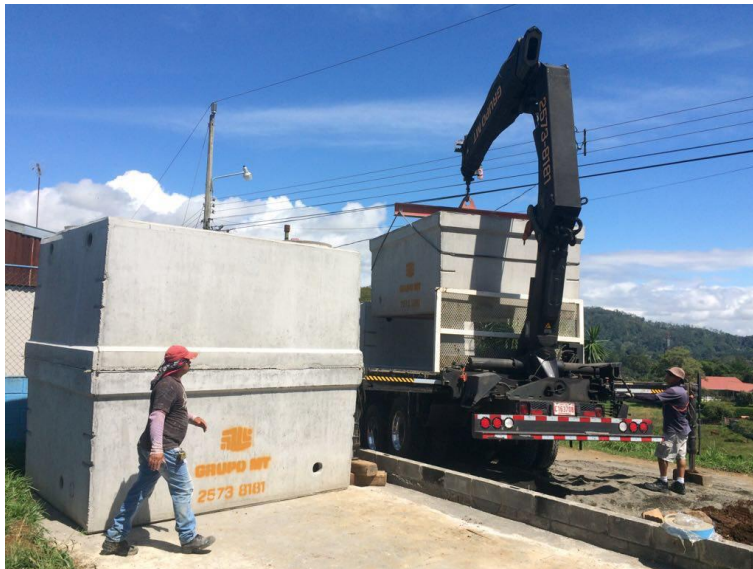
Colocación de 3 tanques de concreto prefabricado para mejorar la capacidad de almacenamiento de agua.
