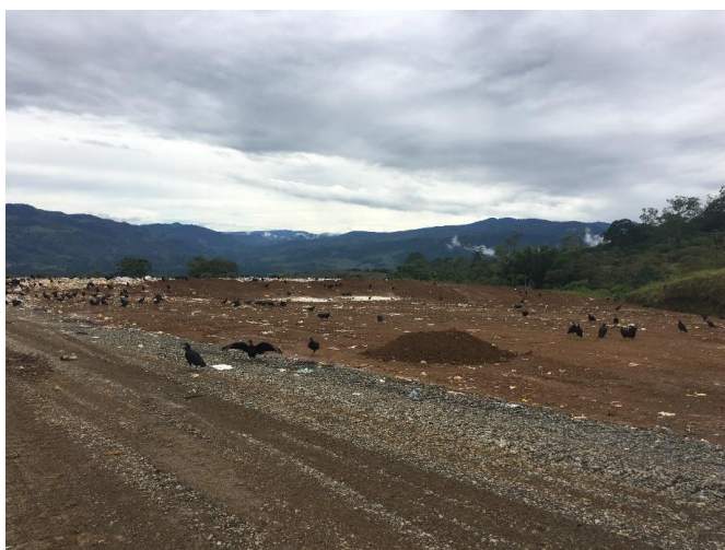
Mantenimiento del camino interno que lleva al frente de trabajo.
