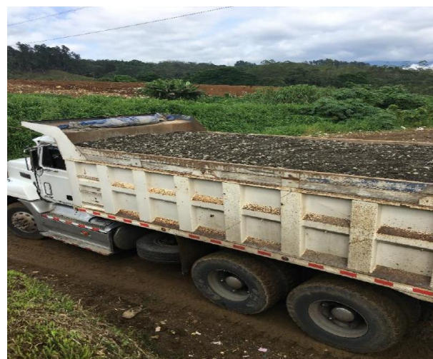
Ingreso de vagonetas con lastre para el mantenimiento de caminos internos.
